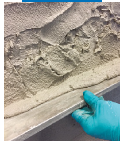
Staggiatura di PoroMap Deumidificante
