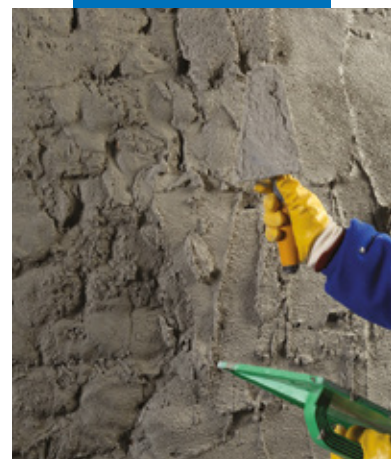
Applicazione di PoroMap Deumidificante a cazzuola
