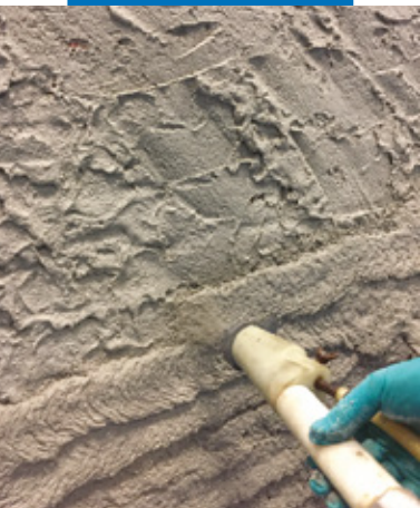
Particolare della fase applicativa
