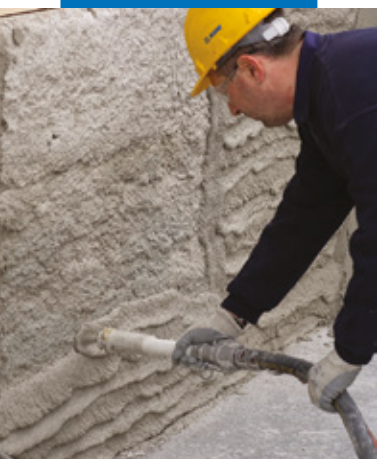
Applicazione di PoroMap Deumidificante con intonacatrice
