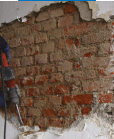
Demolizione dell'intonaco esistente
